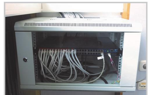
*Netzwerk-switch-Anbindung der einzelnen Klassenzimmer an das Glasfasernetz*
